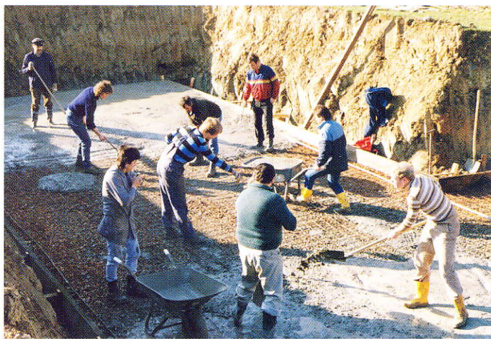
Aktive beim Bau des Mehrzweckgebäudes in der Zissenbach – Ende März 1987
